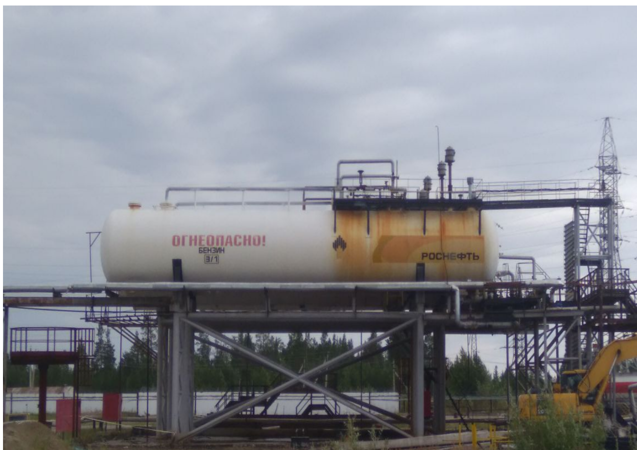
Рисунок 1 - Общий вид резервуара стального горизонтального цилиндрического РГС-200
