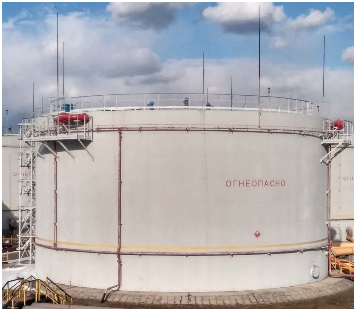
Рисунок 1 - Общий вид резервуара стального вертикального цилиндрического РВС-5000
