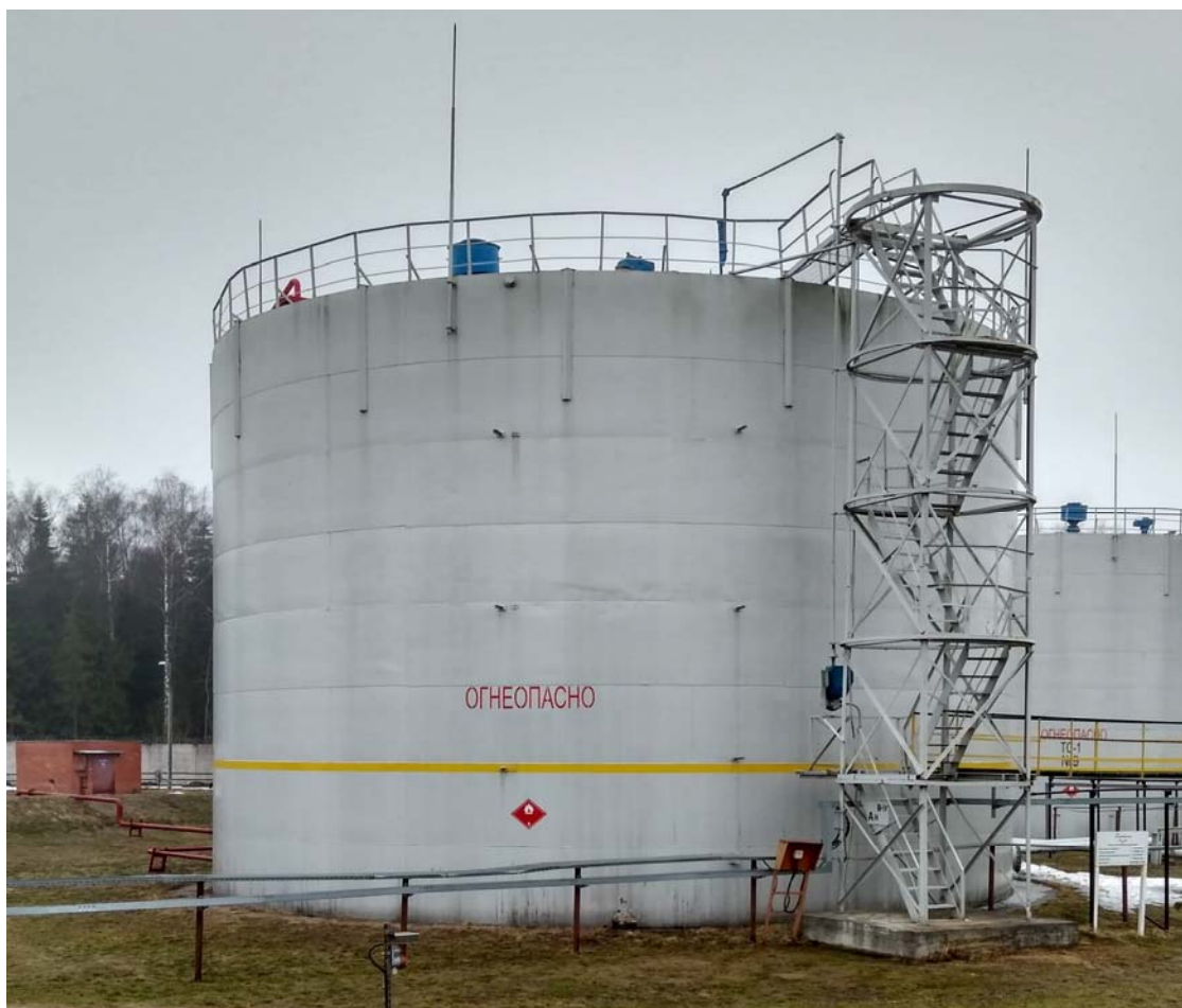
Рисунок 1 - Общий вид резервуара стального вертикального цилиндрического РВС-2000
