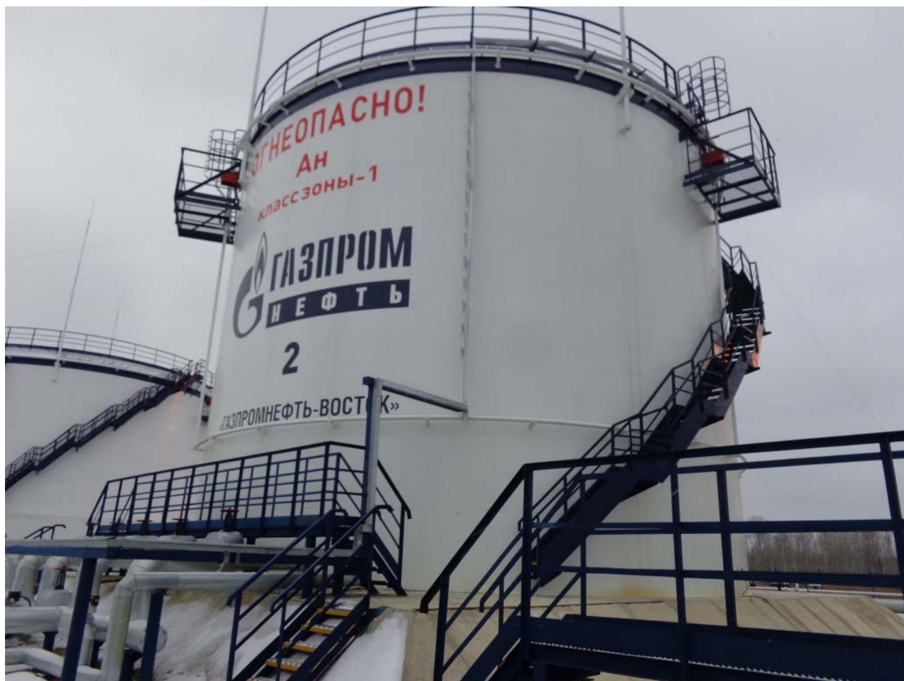
Рисунок 1 - Общий вид резервуаров РВС-2000
