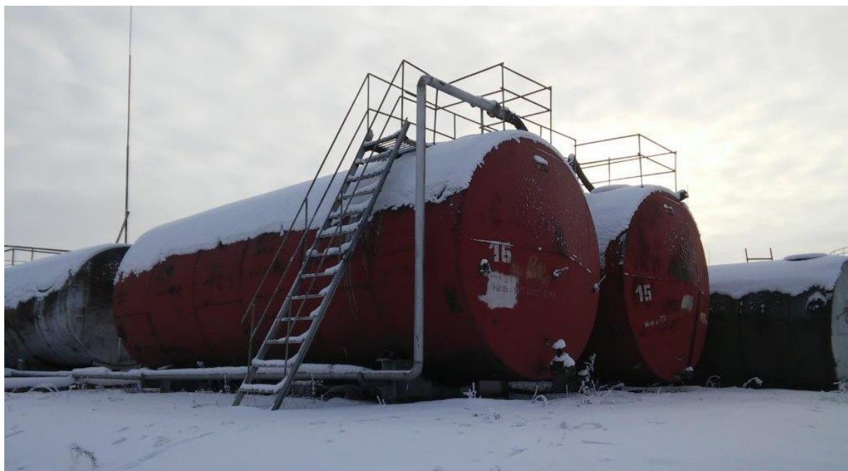
Рисунок 3 - Общий вид резервуара РГС-75
