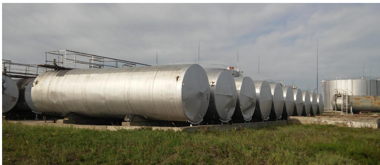
Рисунок 2 - Общий вид резервуара РГС-60
