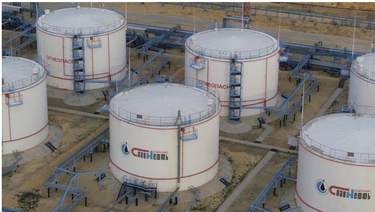
Рисунок 1 - Общий вид резервуаров вертикальных стальных цилиндрических РВС-3000
