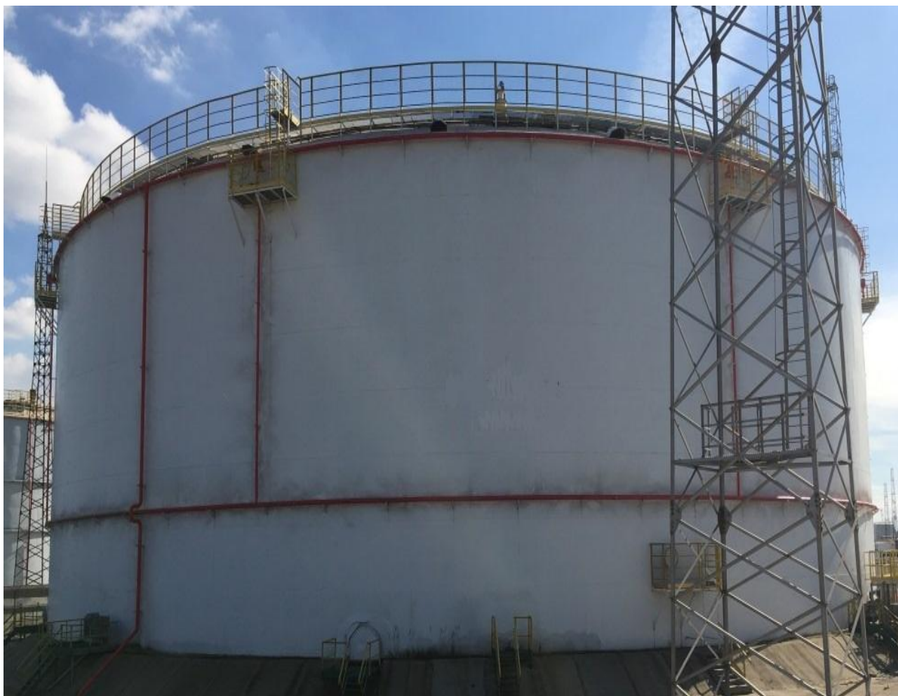
Рисунок 1 - Общий вид резервуара стального вертикального цилиндрического РВСП-50000
