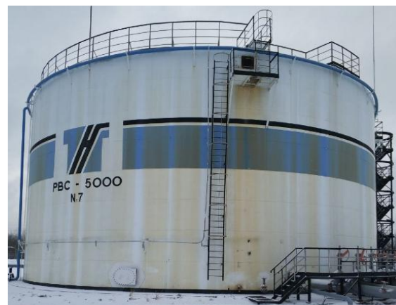
Рисунок 2 - Общий вид резервуара РВС-5000 № 7
