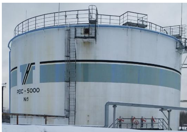
Рисунок 1 - Общий вид резервуара РВС-5000 № 6
