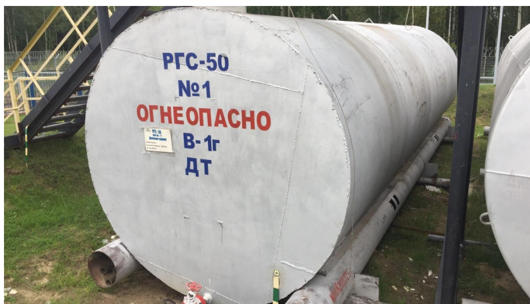
Рисунок 3 - Общий вид резервуара стального горизонтального цилиндрического РГС-50
