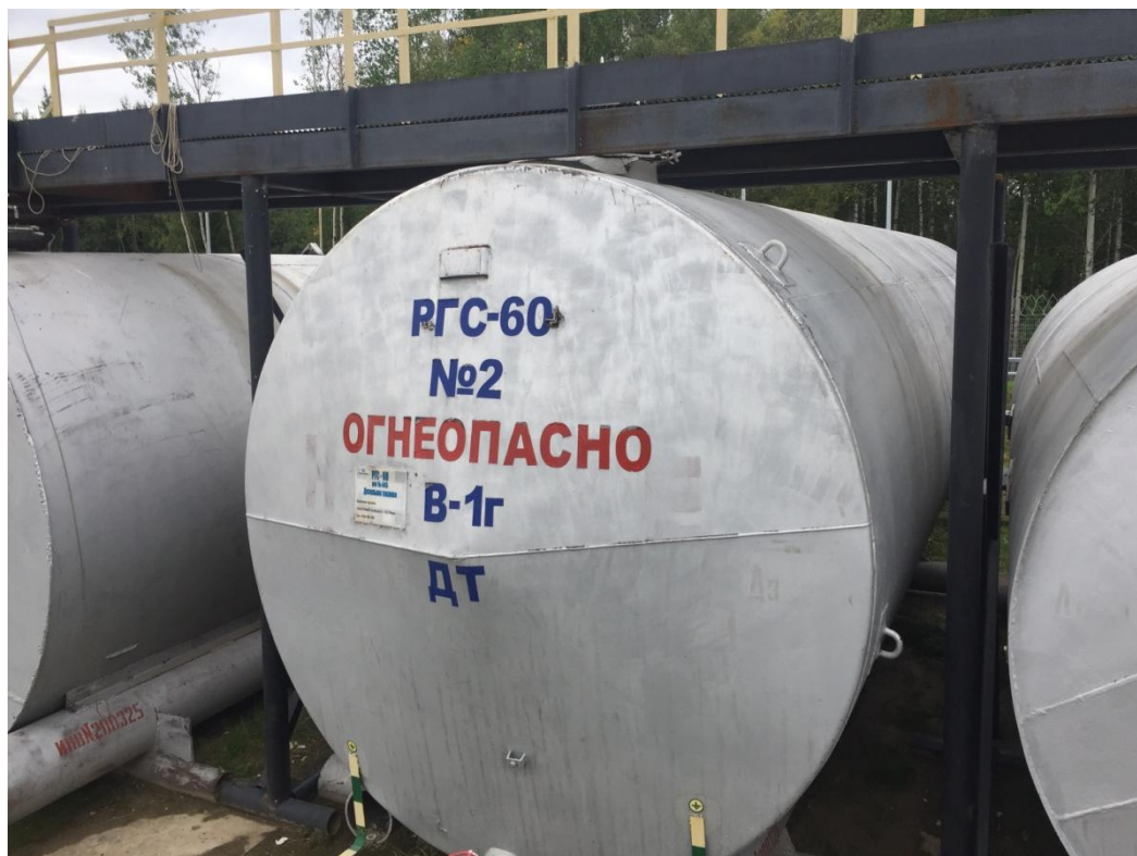
Рисунок 4 - Общий вид резервуара стального горизонтального цилиндрического РГС-60
