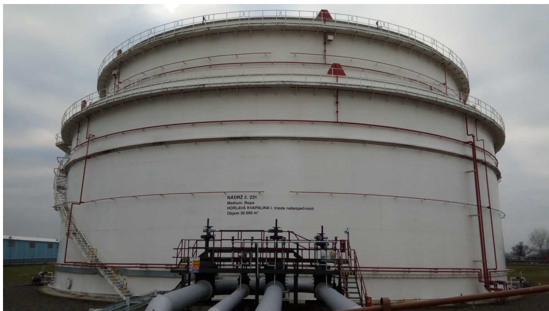
Рисунок 1 - Общий вид резервуара РВСПК-30000
