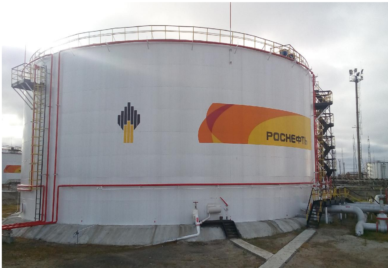
Рисунок 1 - Общий вид резервуара стального вертикального цилиндрического РВС-10000
