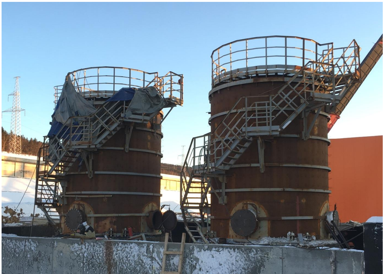
Рисунок 1 - Общий вид резервуаров
