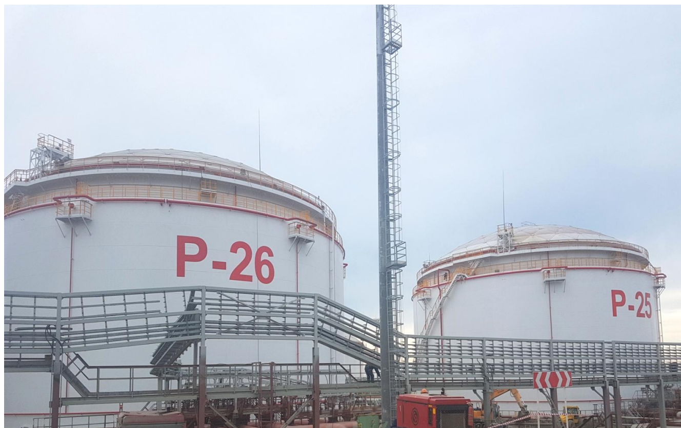
Рисунок 1 - Общий вид резервуаров
