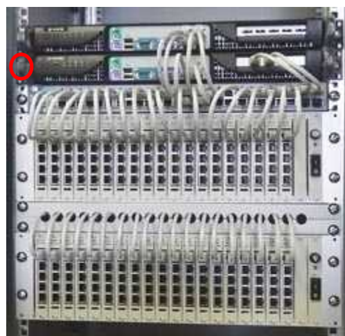
Рисунок 2 - Место пломбирования элемента системы коммутации КАТС «М-200»
