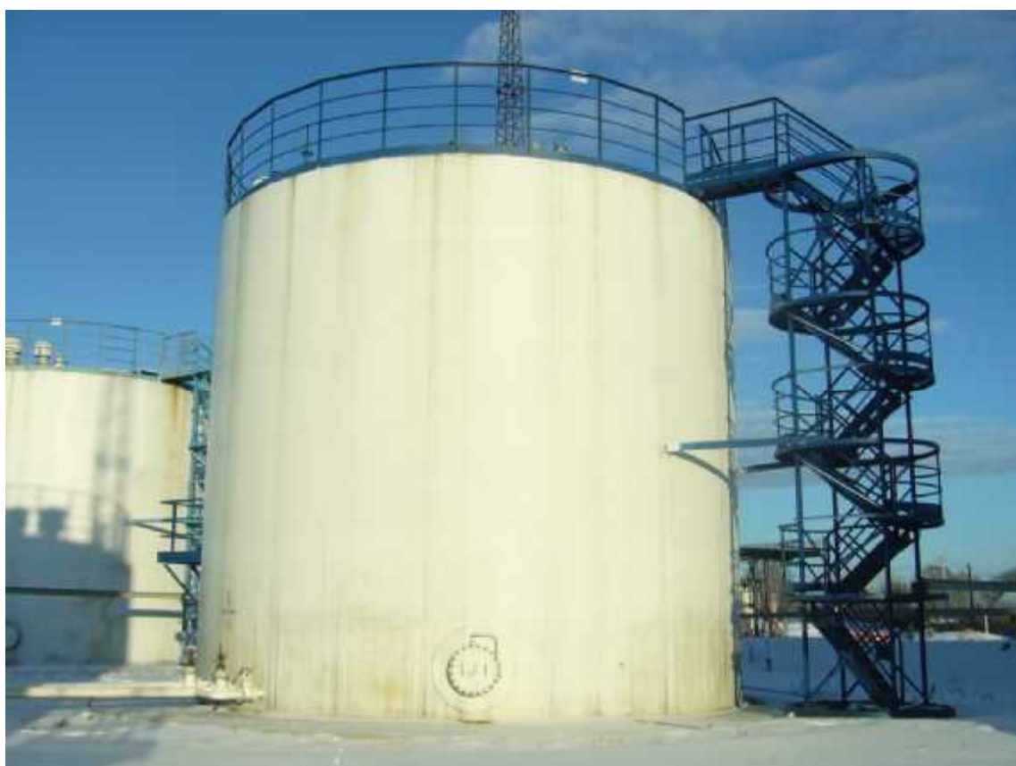
Рисунок 3 - Общий вид резервуаров вертикальных стальных цилиндрических РВСPI-700
