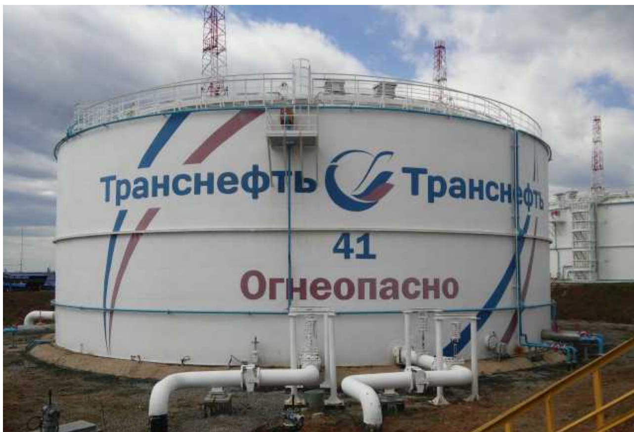
Рисунок 2 - Общий вид резервуара вертикального стального цилиндрического РВС-10000
