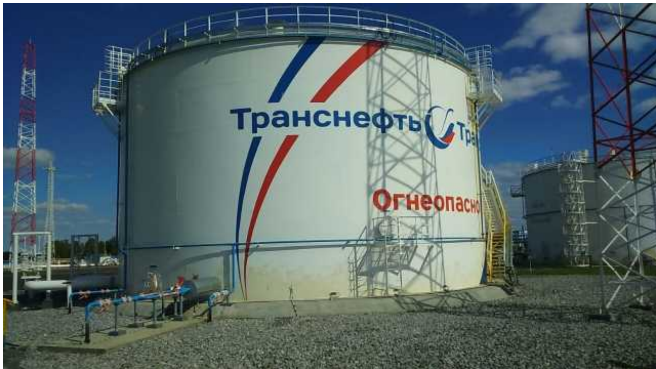
Рисунок 1 - Общий вид резервуара вертикального стального цилиндрического РВС-5000
