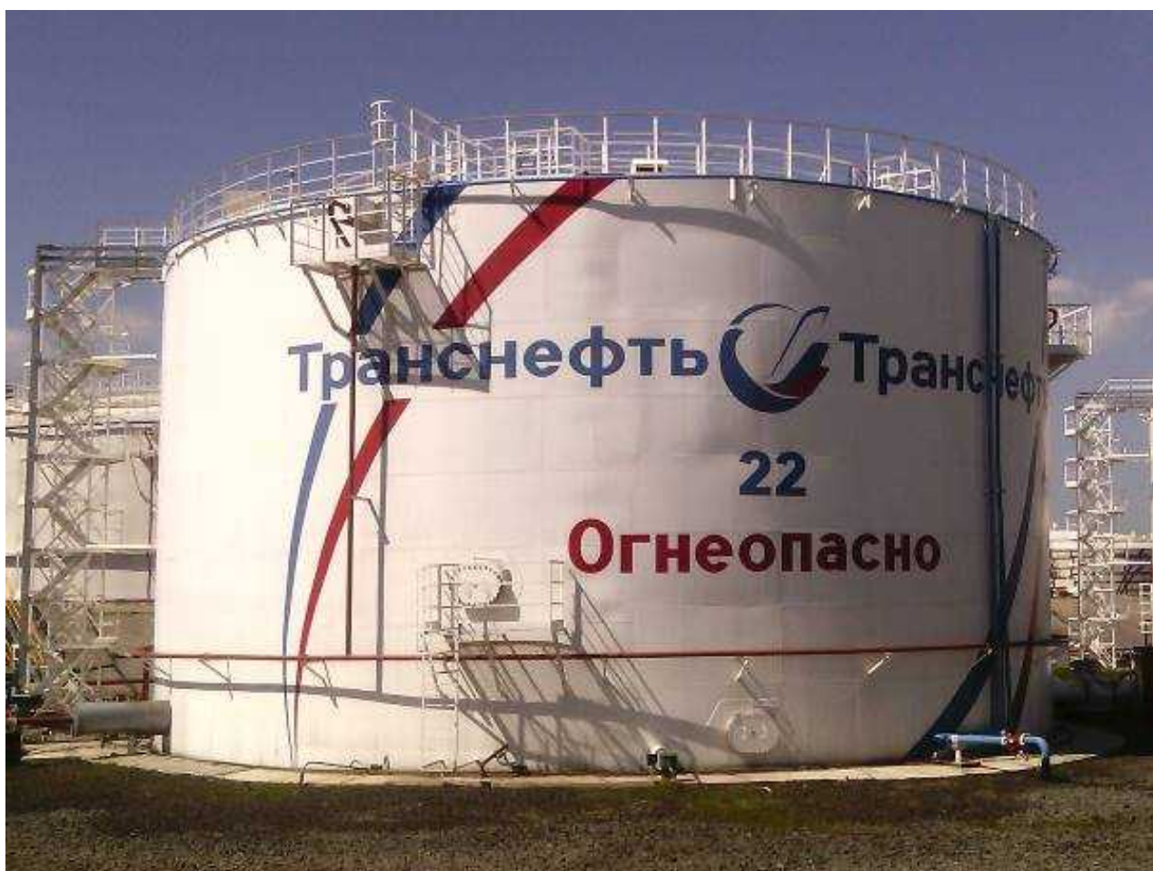
Рисунок 1 - Общий вид резервуара вертикального стального цилиндрического РВСП-5000
