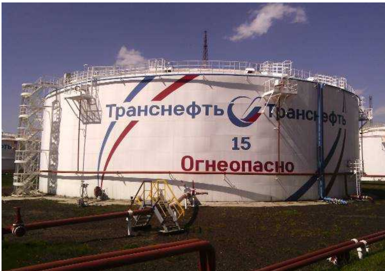
Рисунок 2 - Общий вид резервуара вертикального стального цилиндрического РВСП-20000
