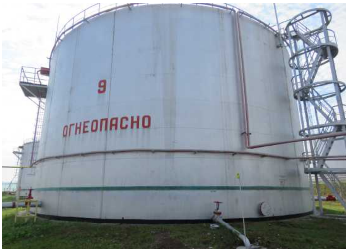
Рисунок 1 - Общий вид резервуара РВС-5000
