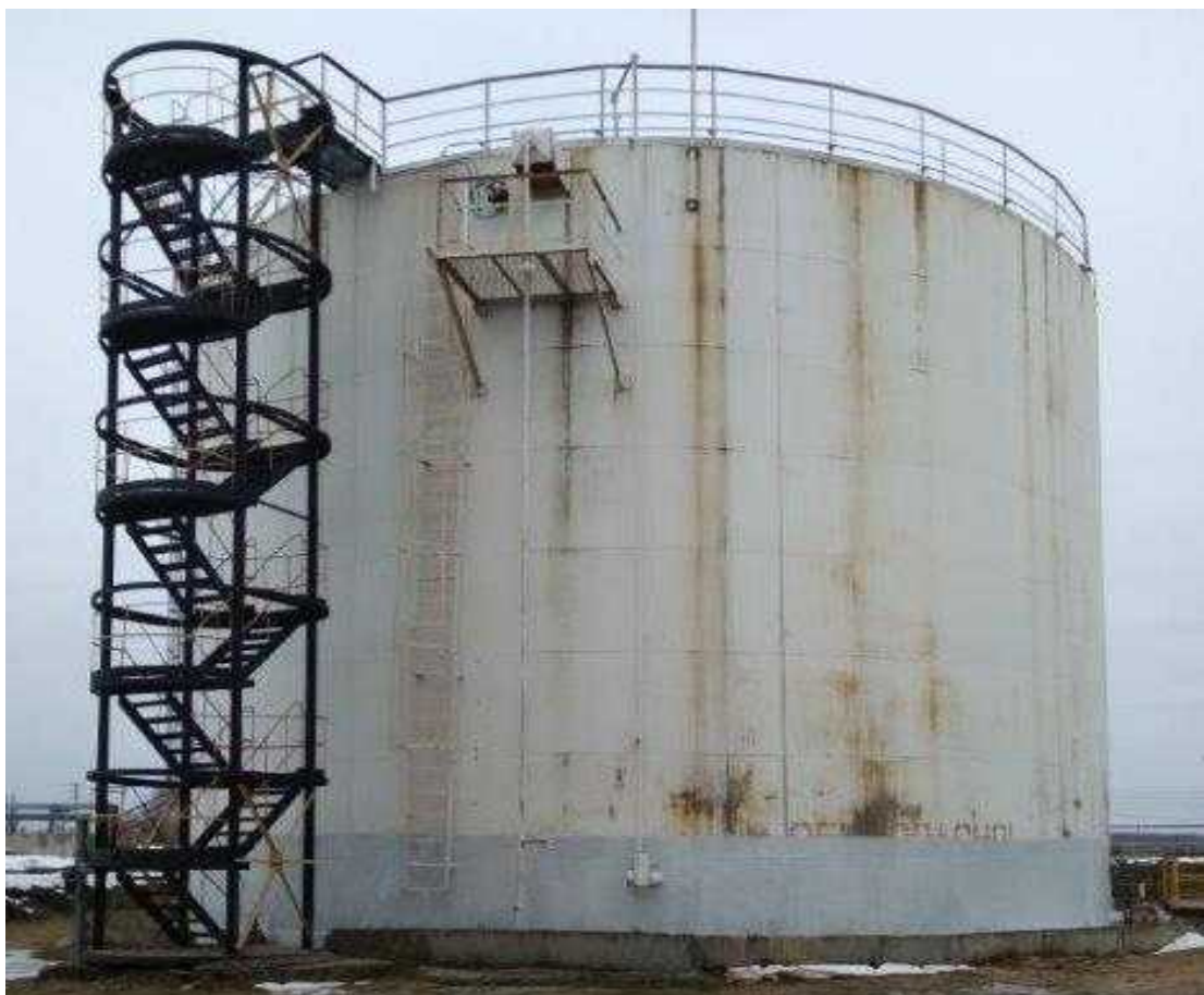
Рисунок 2 - Общий вид резервуара стального вертикального цилиндрического РВС-2000
