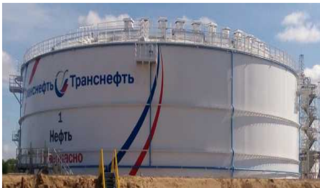
Рисунок 2 - Общий вид резервуара вертикального стального цилиндрического РВС-20000
