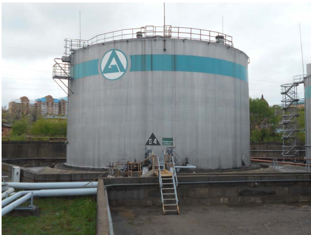
Рисунок 2 - Общий вид резервуара РВС- 4000 № 64
