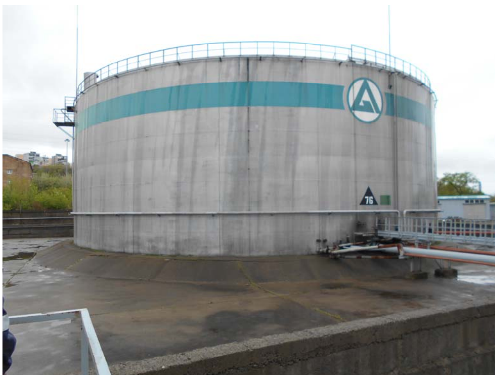
Рисунок 11 - Общий вид резервуара РВС- 10000 № 76
