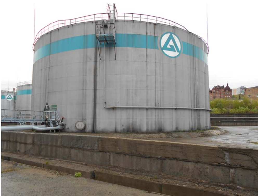
Рисунок 10 - Общий вид резервуара РВС- 8000 № 77
