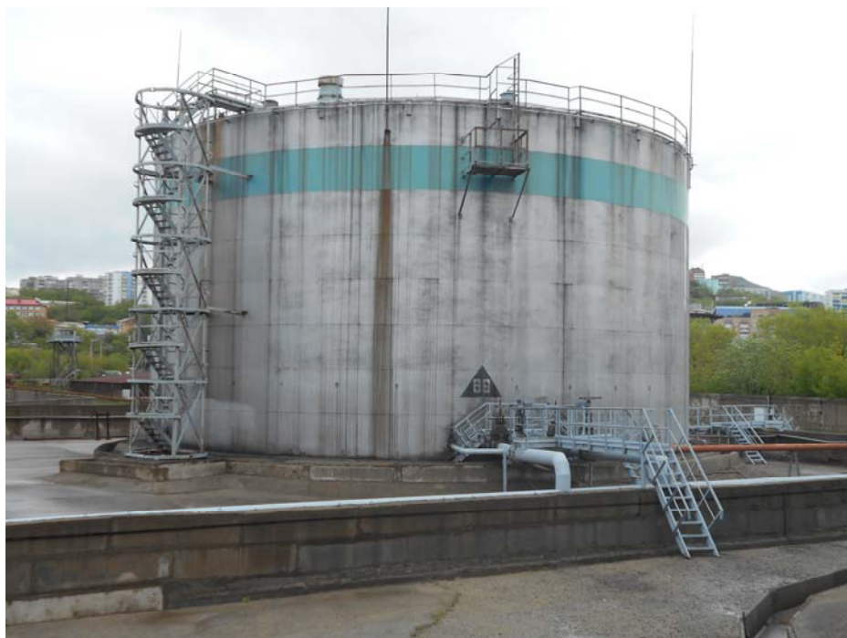
Рисунок 7 - Общий вид резервуара РВС- 5000 № 69
