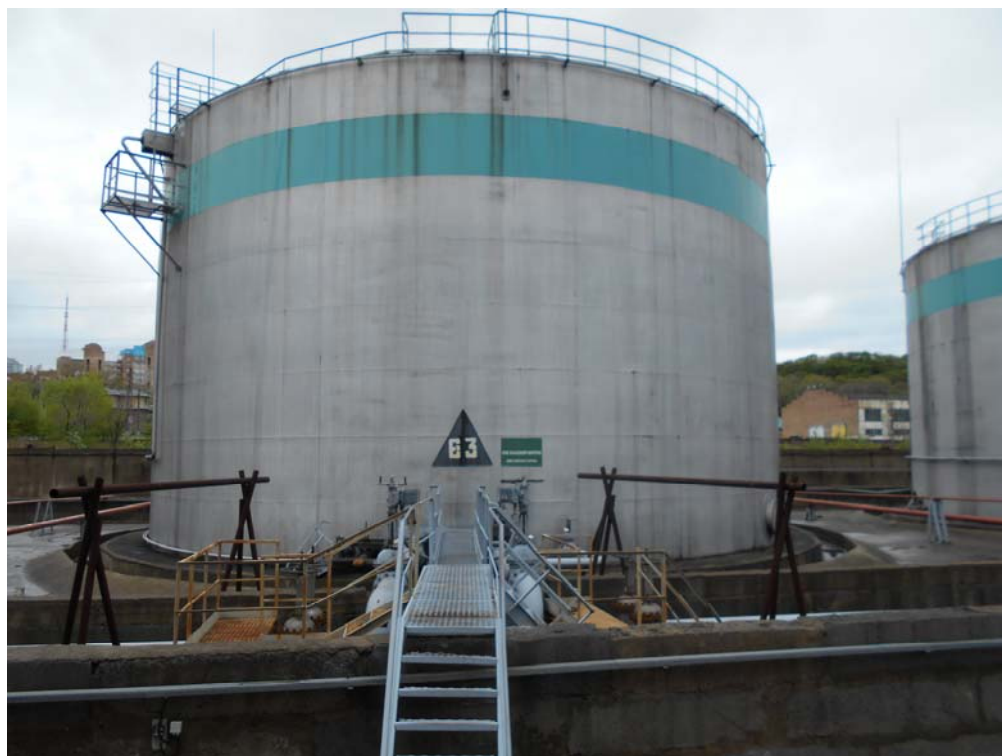
Рисунок 1 - Общий вид резервуара РВС- 4000 № 63
