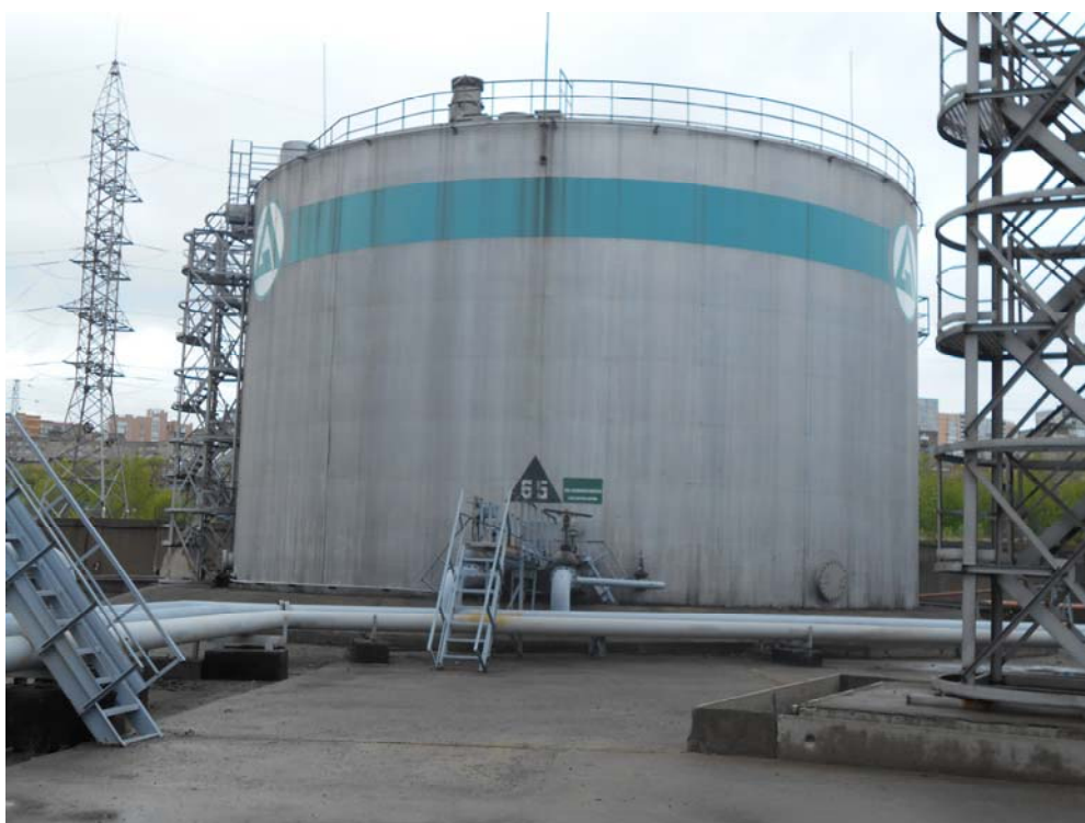
Рисунок 3 - Общий вид резервуара РВС- 4000 № 65
