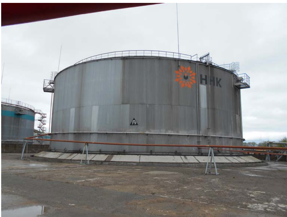
Рисунок 13 - Общий вид резервуара РВС- 10000 № 79
