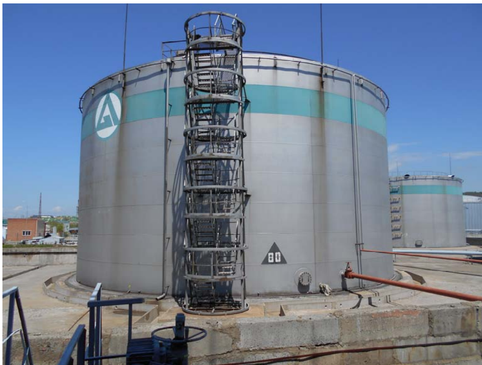
Рисунок 8 - Общий вид резервуара РВС- 5000 № 80
