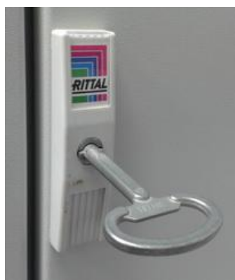
Рисунок 24 - Замок и ключ шкафа кроссового. Вид внешний
