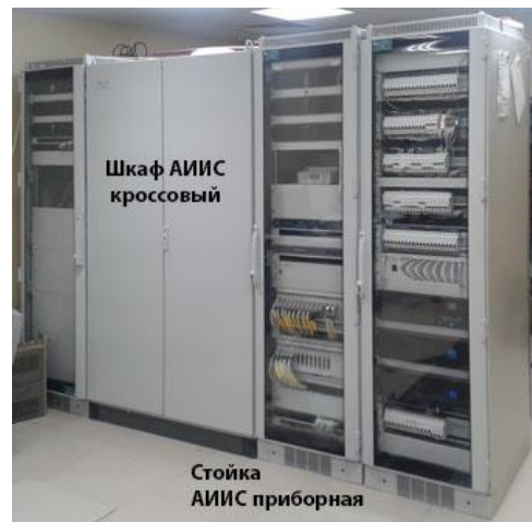
Рисунок 2 - Стойки и шкафы АИИС. Расположение
