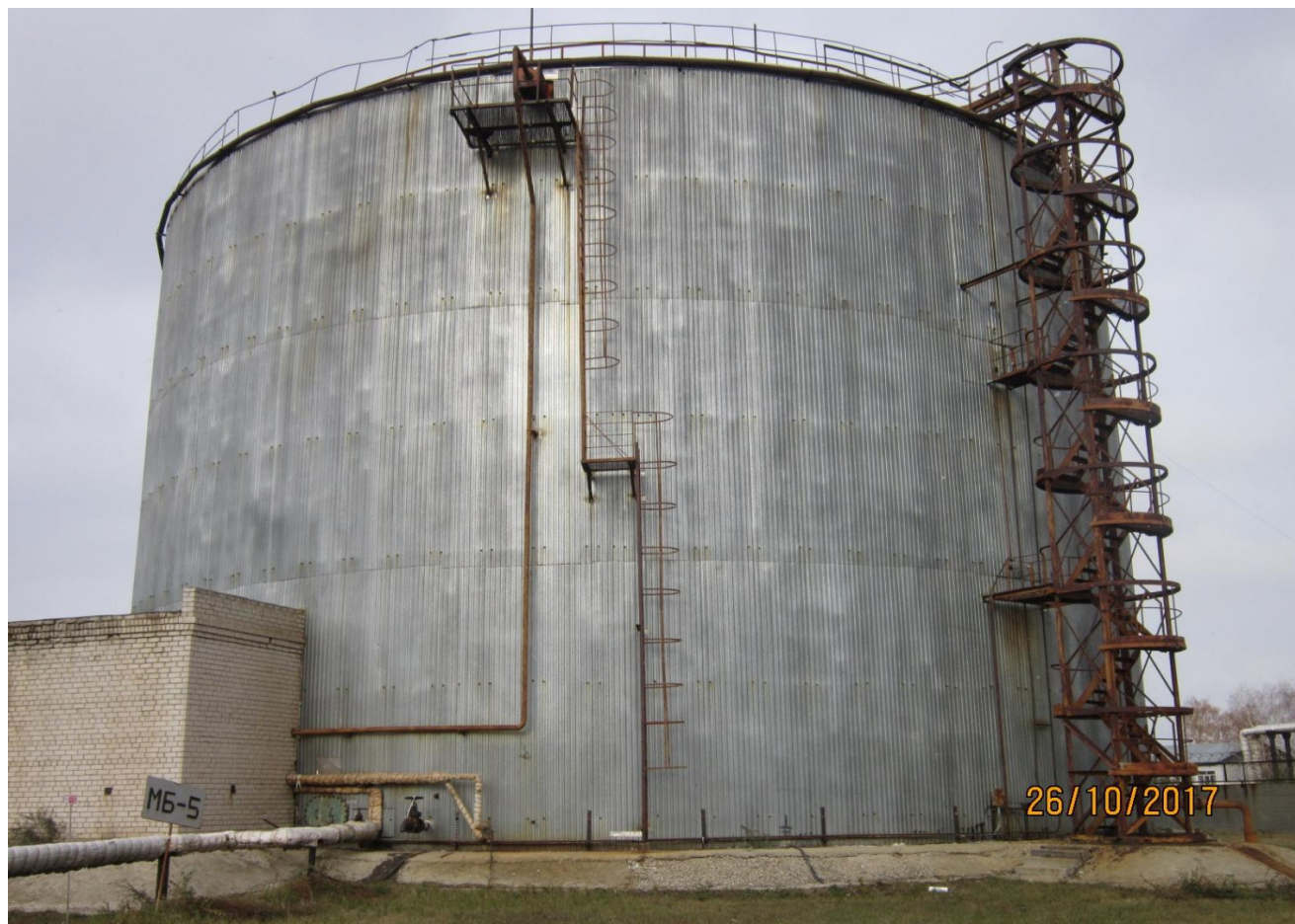
Фото 2 - Общий вид резервуара РВС-11000
