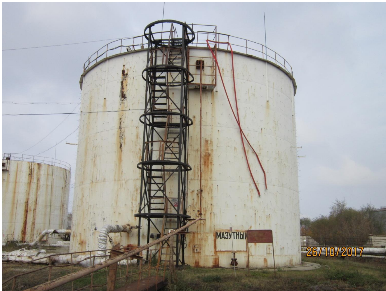
Фото 1 - Общий вид резервуара РВС-2000
