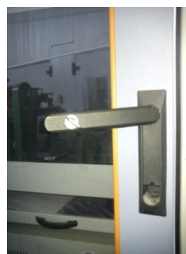
Рисунок 10 - Внешний вид замка на дверце стойки управления
