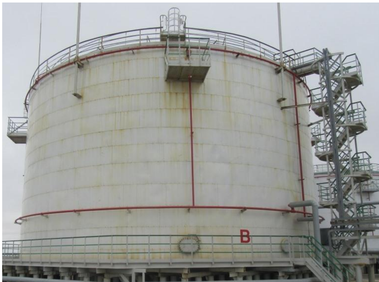
Рисунок 1 - Общий вид резервуара стального вертикального цилиндрического РВС-5000
