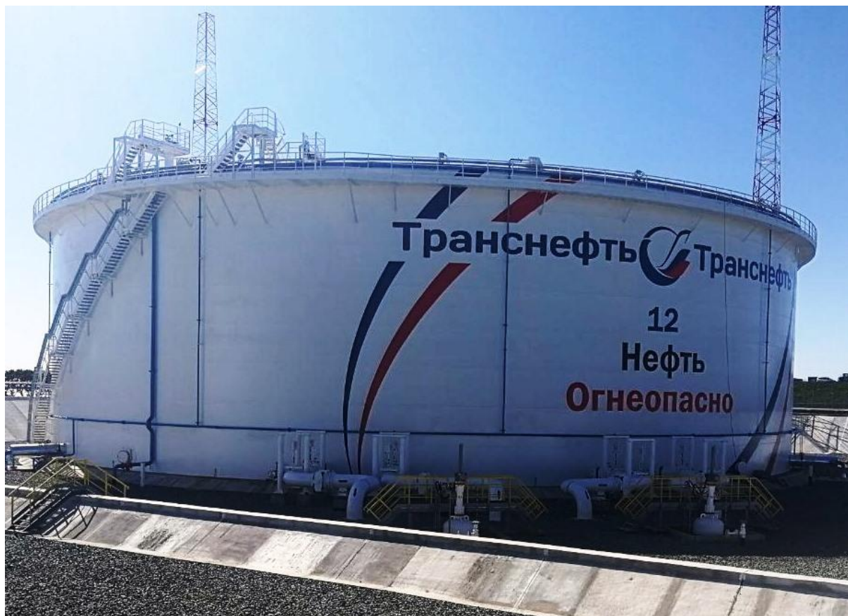
Рисунок 1 - Общий вид резервуара РВСПК-50000
