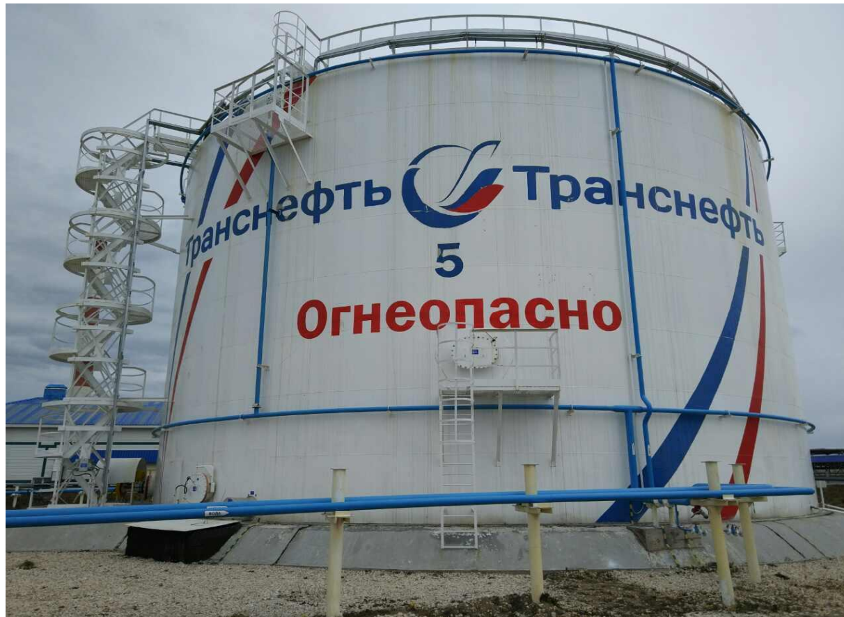
Рисунок 2 - Общий вид резервуара вертикального стального цилиндрического РВСП-5000
