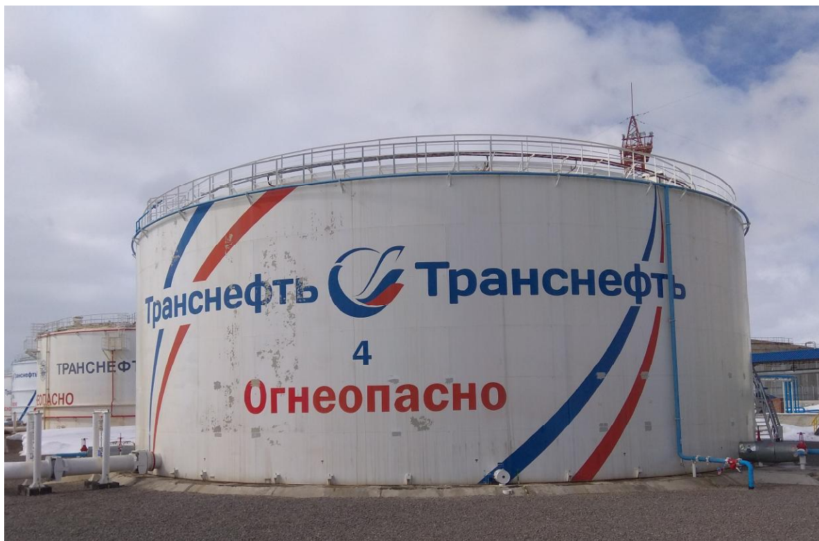
Рисунок 1 - Общий вид резервуара вертикального стального цилиндрического РВС-10000
