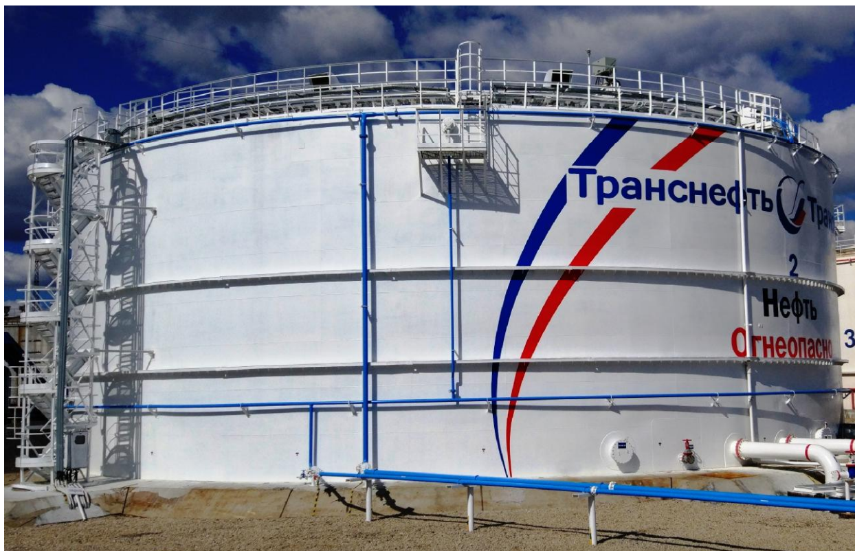
Рисунок 3 - Общий вид резервуара вертикального стального цилиндрического РВСП-10000
