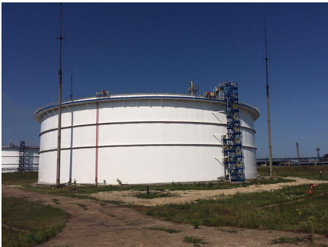
Рисунок 1 - Общий вид резервуара РВСПК-50000
