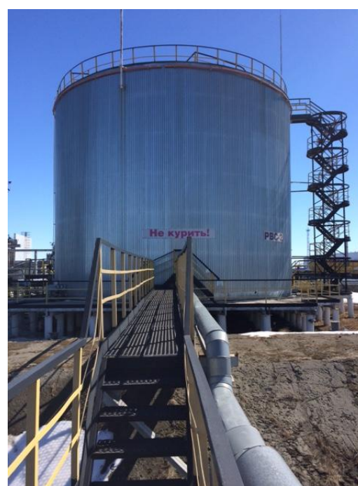
Рисунок 1 - Общий вид резервуаров вертикальных стальных цилиндрических РВС-2000, расположенных на ВУ ЛУ
