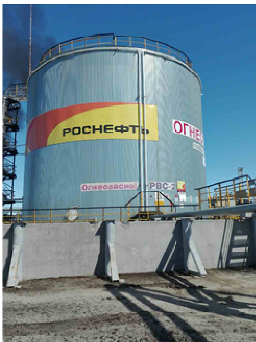
Рисунок 2 - Общий вид резервуаров вертикальных стальных цилиндрических РВС-2000, расположенных на НУ ЛУ
