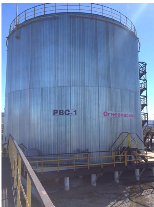
Рисунок 1 - Общий вид резервуаров вертикальных стальных цилиндрических РВС-2000, расположенных на ВУ ЛУ
