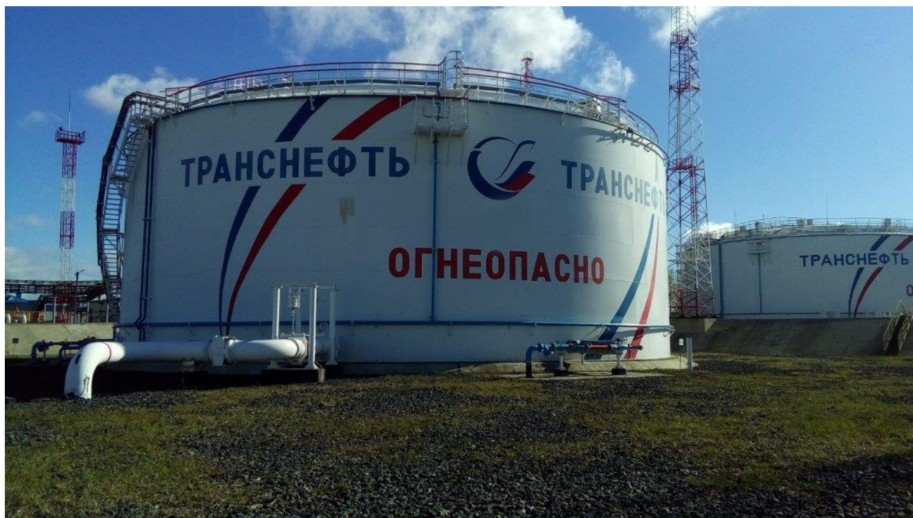
Рисунок 1 – Общий вид резервуара вертикального стального цилиндрического РВС-10000
