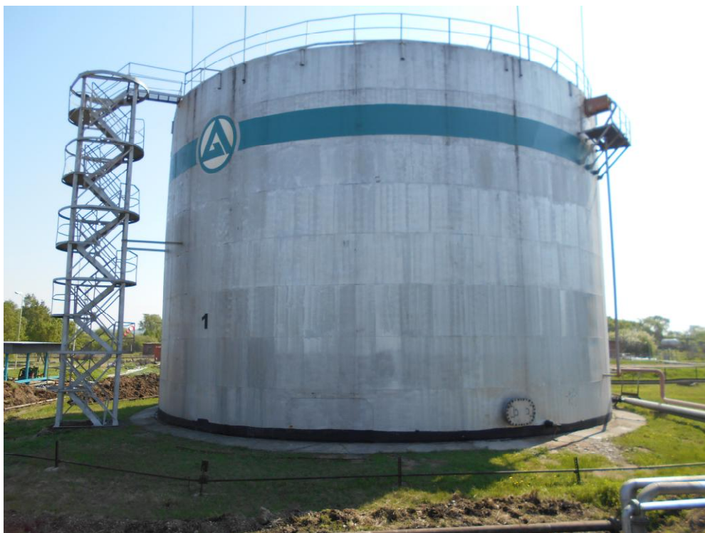
Рисунок 6 - Общий вид резервуара РВС – 3000 № 1
