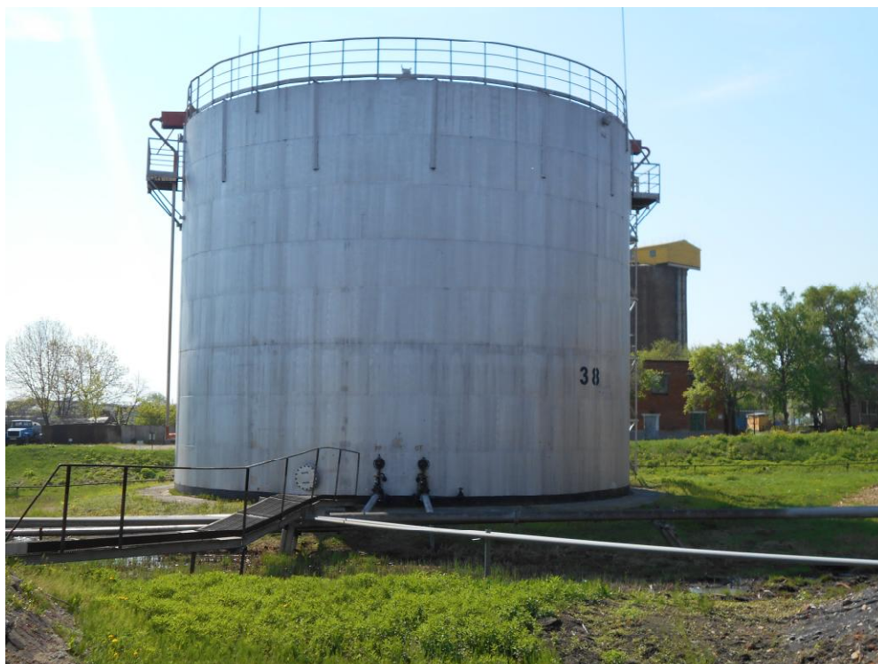
Рисунок 4 - Общий вид резервуара РВС – 2000 № 38
