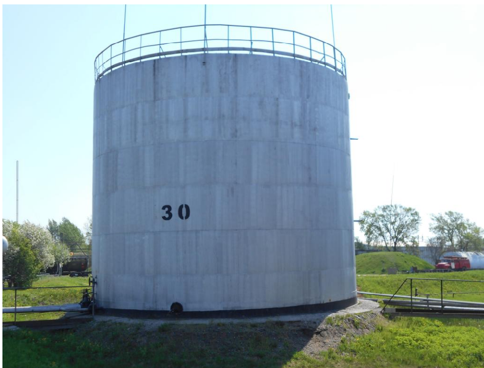
Рисунок 1 - Общий вид резервуара РВС-700 № 30
