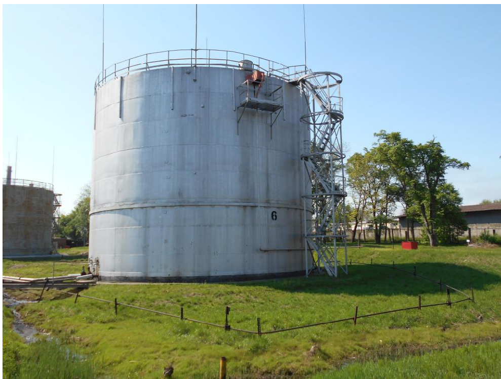
Рисунок 2 - Общий вид резервуара РВС – 2000 № 6
