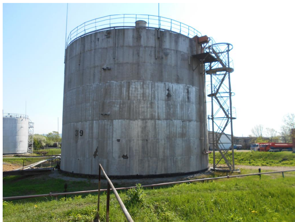
Рисунок 5 - Общий вид резервуара РВС – 2000 № 39
