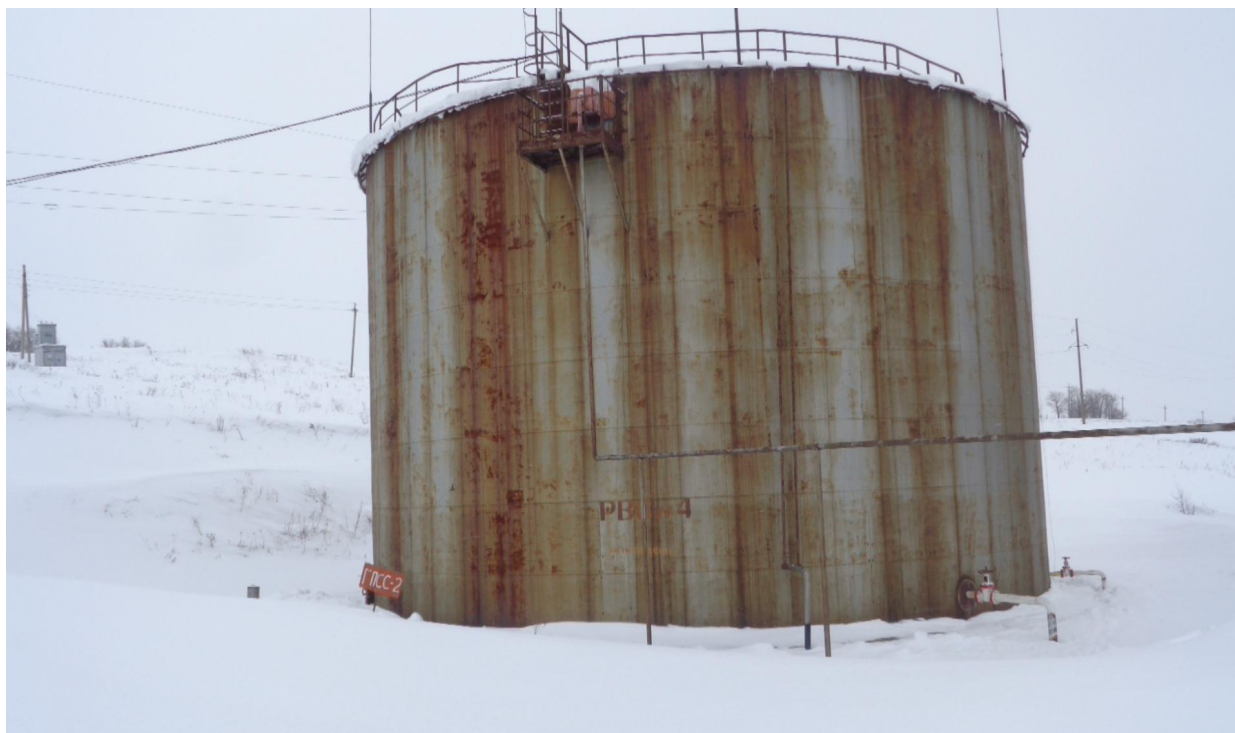
Рисунок 3 - Общий вид резервуара стального вертикального цилиндрического РВС-3000
