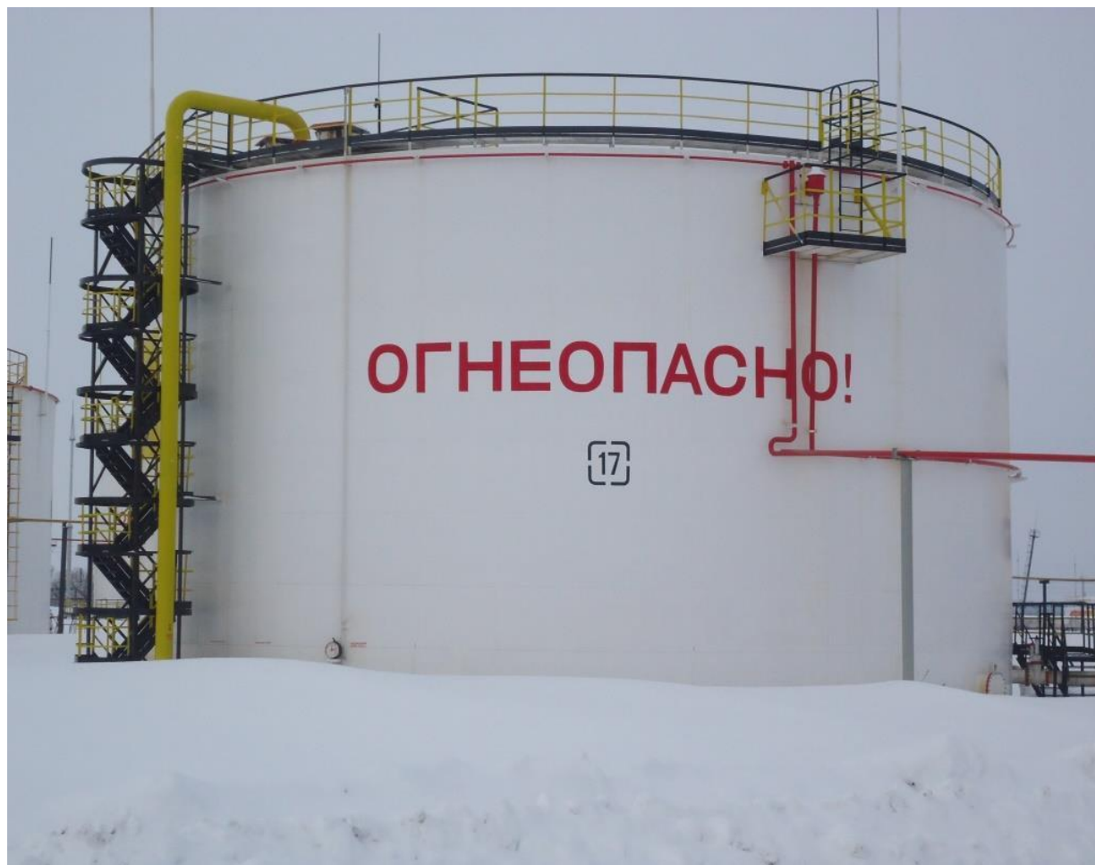
Рисунок 5 - Общий вид резервуара стального вертикального цилиндрического РВС-5000
