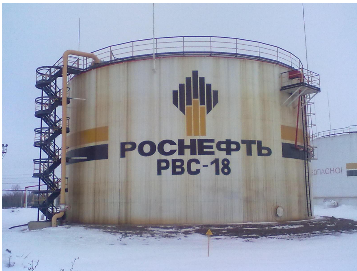
Рисунок 4 - Общий вид резервуара стального вертикального цилиндрического РВС-4000
