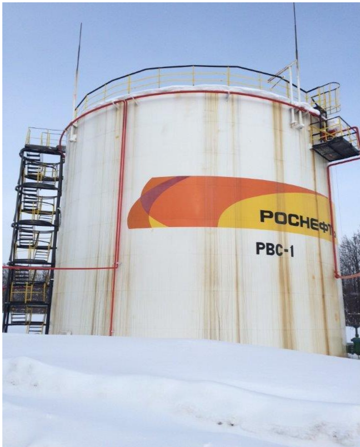
Рисунок 2 - Общий вид резервуара стального вертикального цилиндрического РВС-2000
