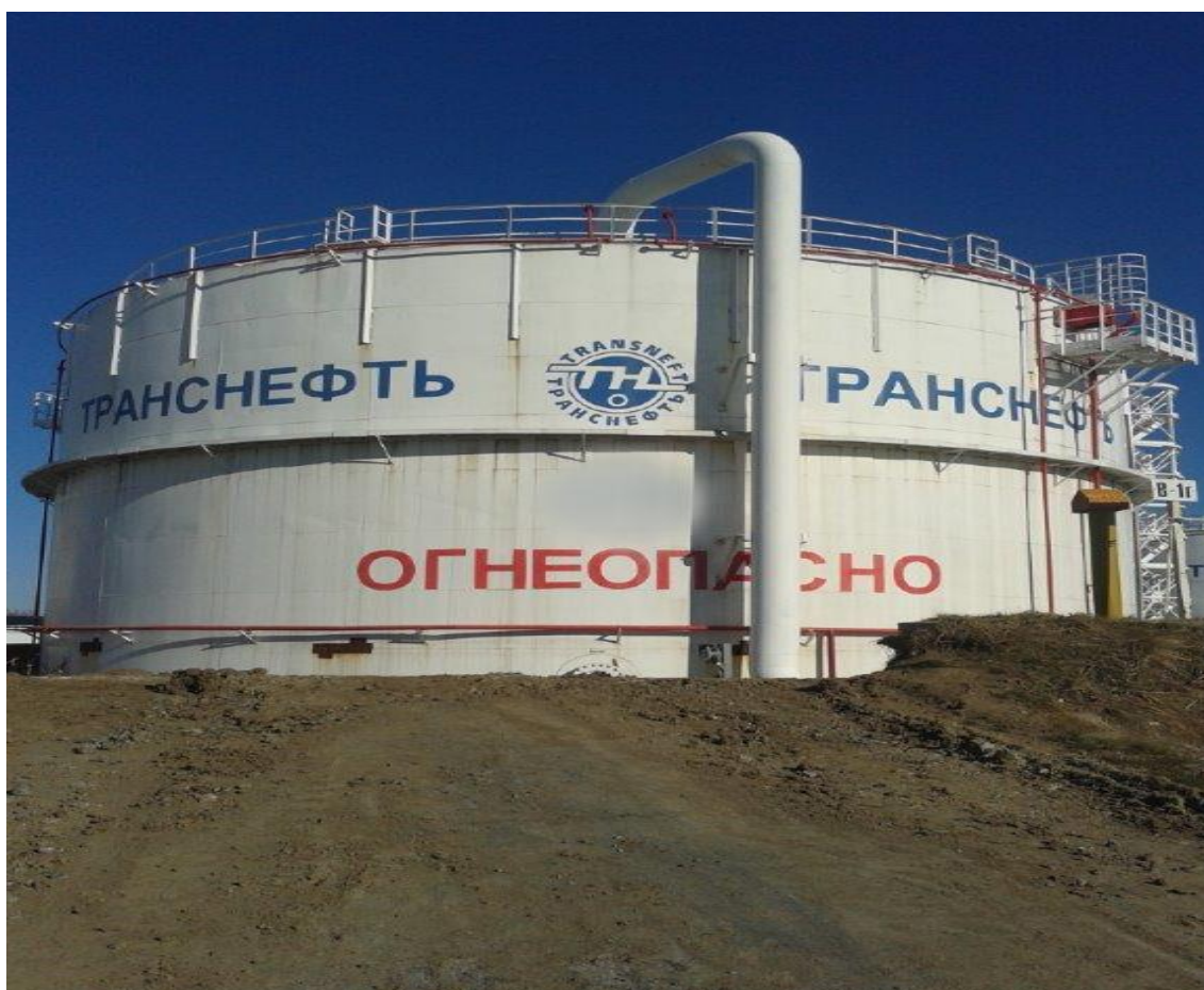
Рисунок 1 – Общий вид резервуара вертикального стального цилиндрического РВС-5000
