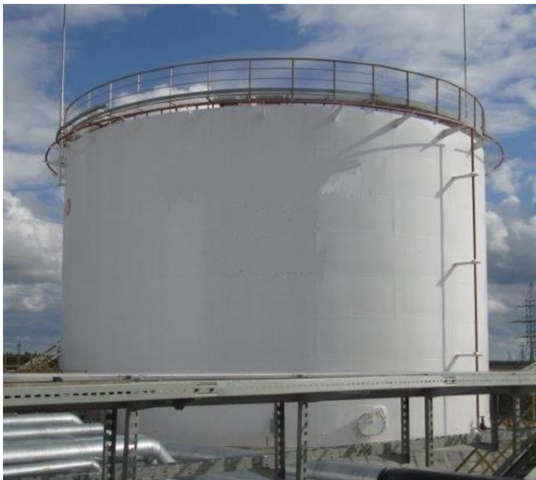
Рисунок 1 - Общий вид резервуара стального вертикального цилиндрического РВС-3000
