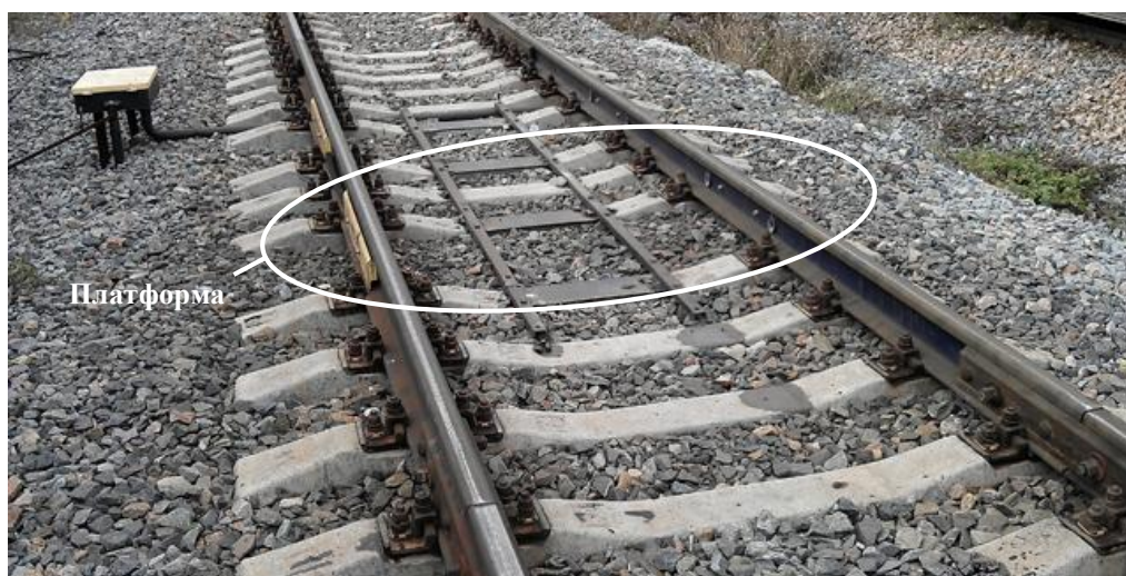
Рисунок 1 – Общий вид ГПУ весов на железобетонных шпалах
