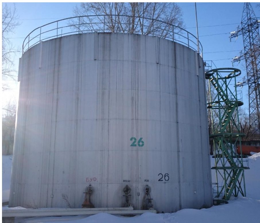
Рисунок 2 - Общий вид резервуара РВС-1000
