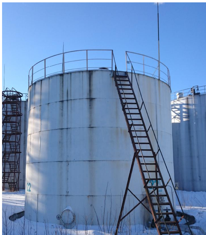
Рисунок 1 - Общий вид резервуара РВС-400
