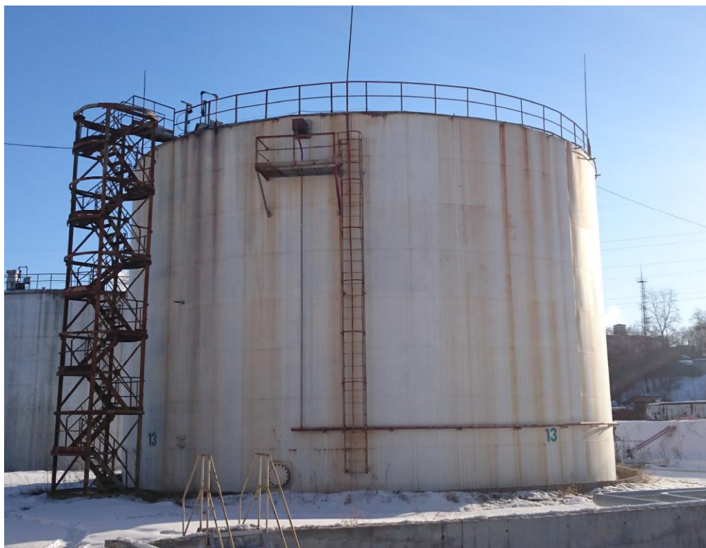
Рисунок 4 - Общий вид резервуара РВС-3000
