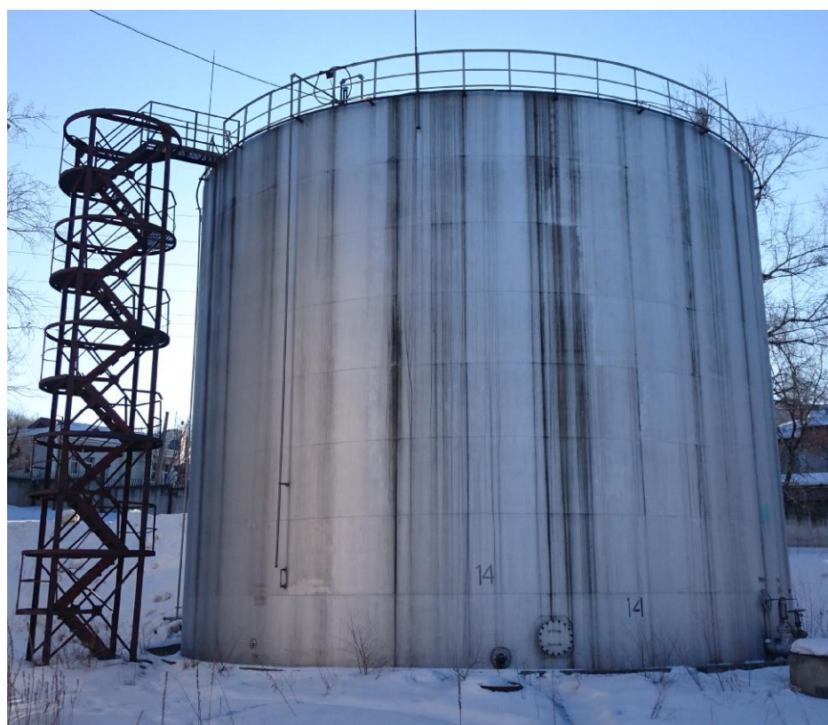
Рисунок 3 - Общий вид резервуара РВС-2000
