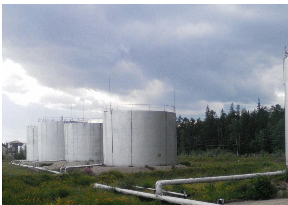
Рисунок 5 - Общий вид резервуара РВС-1000
