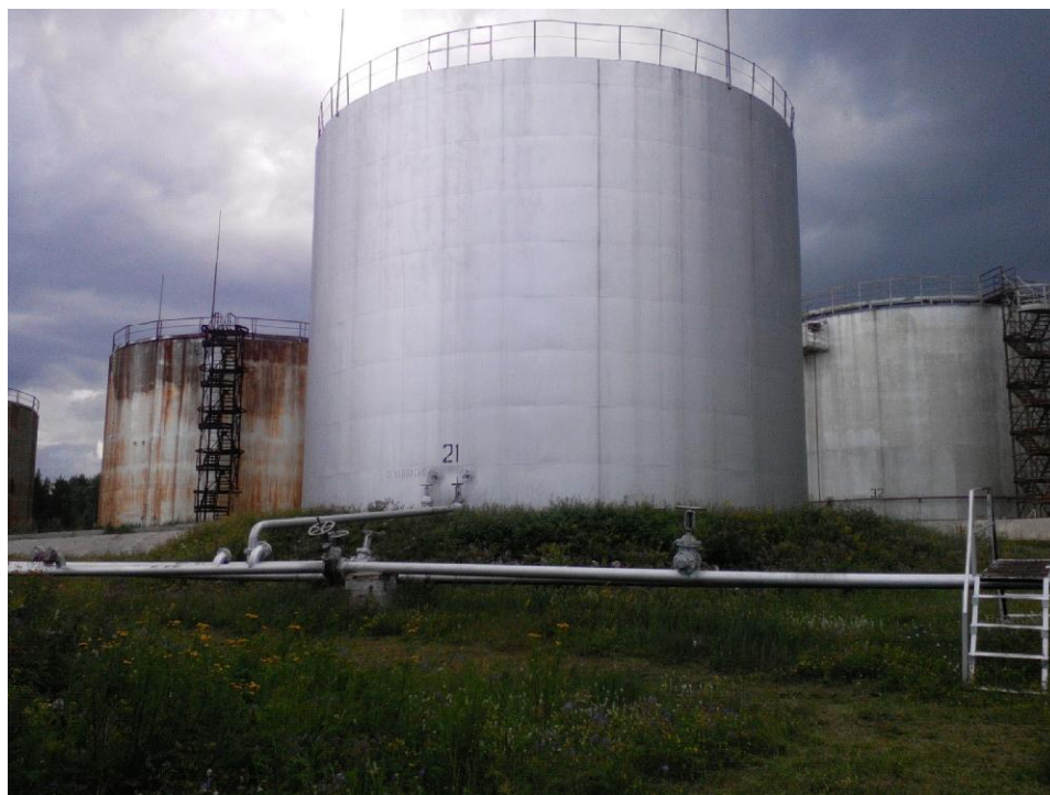
Рисунок 6 - Общий вид резервуара РВС-2000
