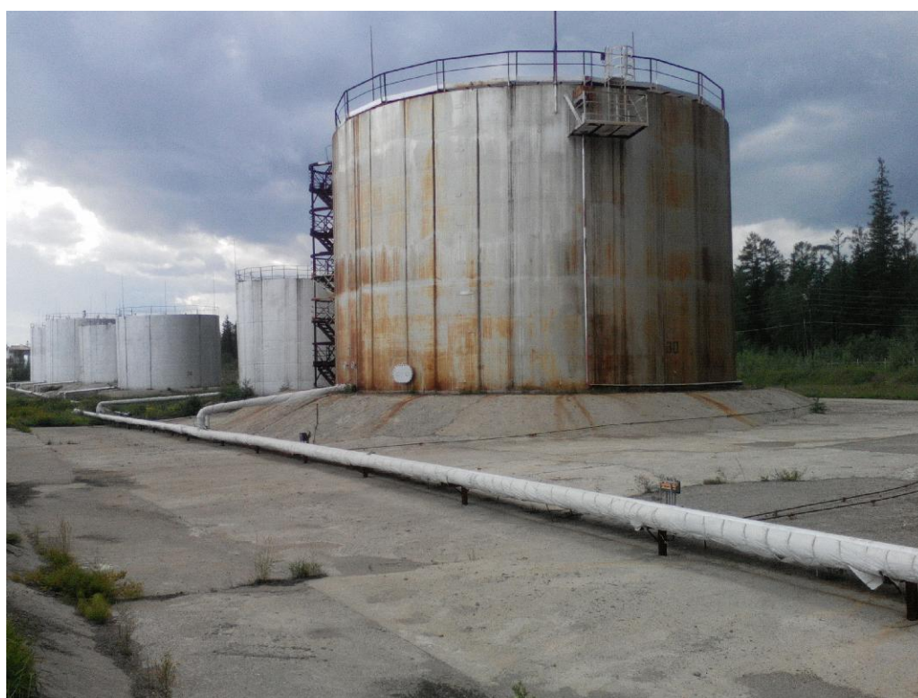
Рисунок 7 - Общий вид резервуара РВС-3000
