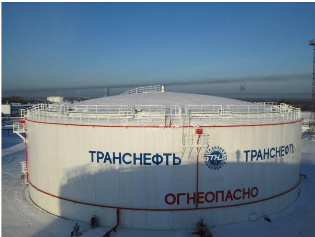
Рисунок 3 – Общий вид резервуара вертикального стального цилиндрического РВСП-20000
