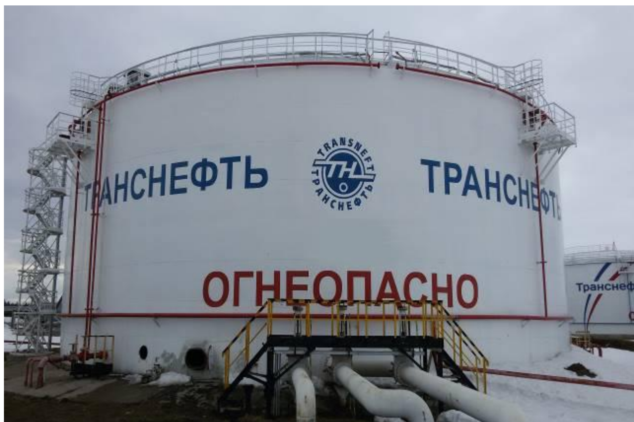
Рисунок 2 – Общий вид резервуара вертикального стального цилиндрического РВСП-1000
