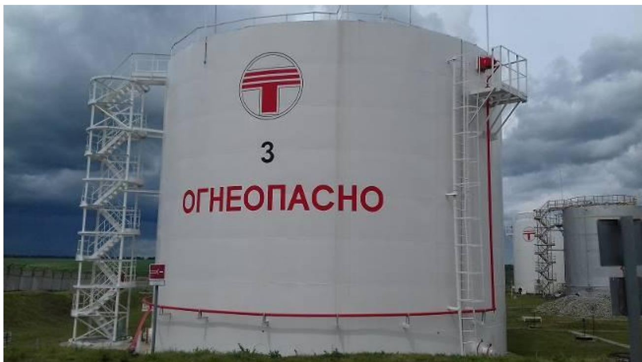
Рисунок 1 – Общий вид резервуара вертикального стального цилиндрического РВС-2000
