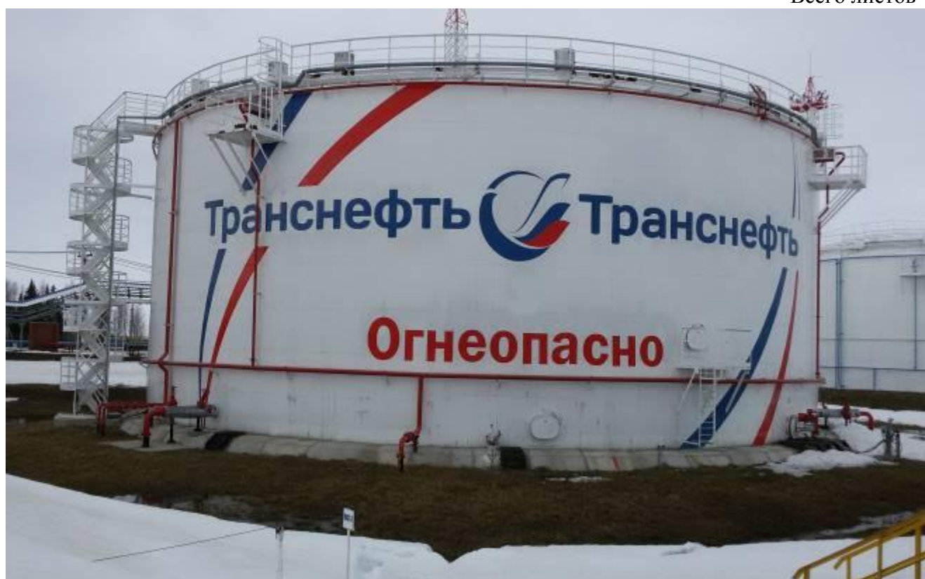
Рисунок 2 – Общий вид резервуара вертикального стального цилиндрического РВСП-3000
