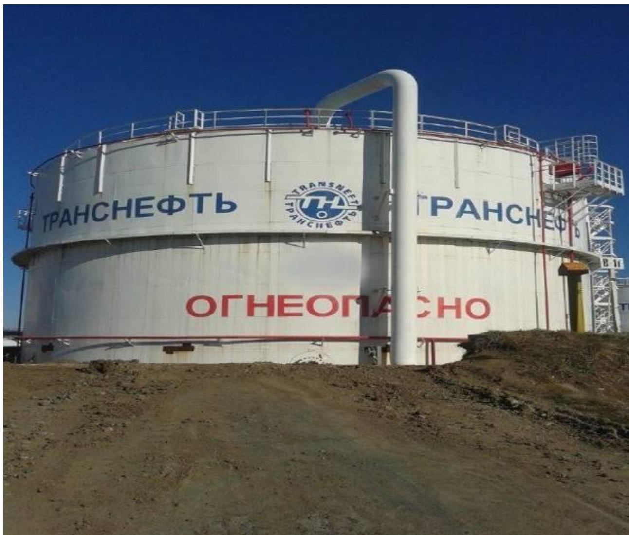
Рисунок 1 – Общий вид резервуара вертикального стального цилиндрического РВС-3000
