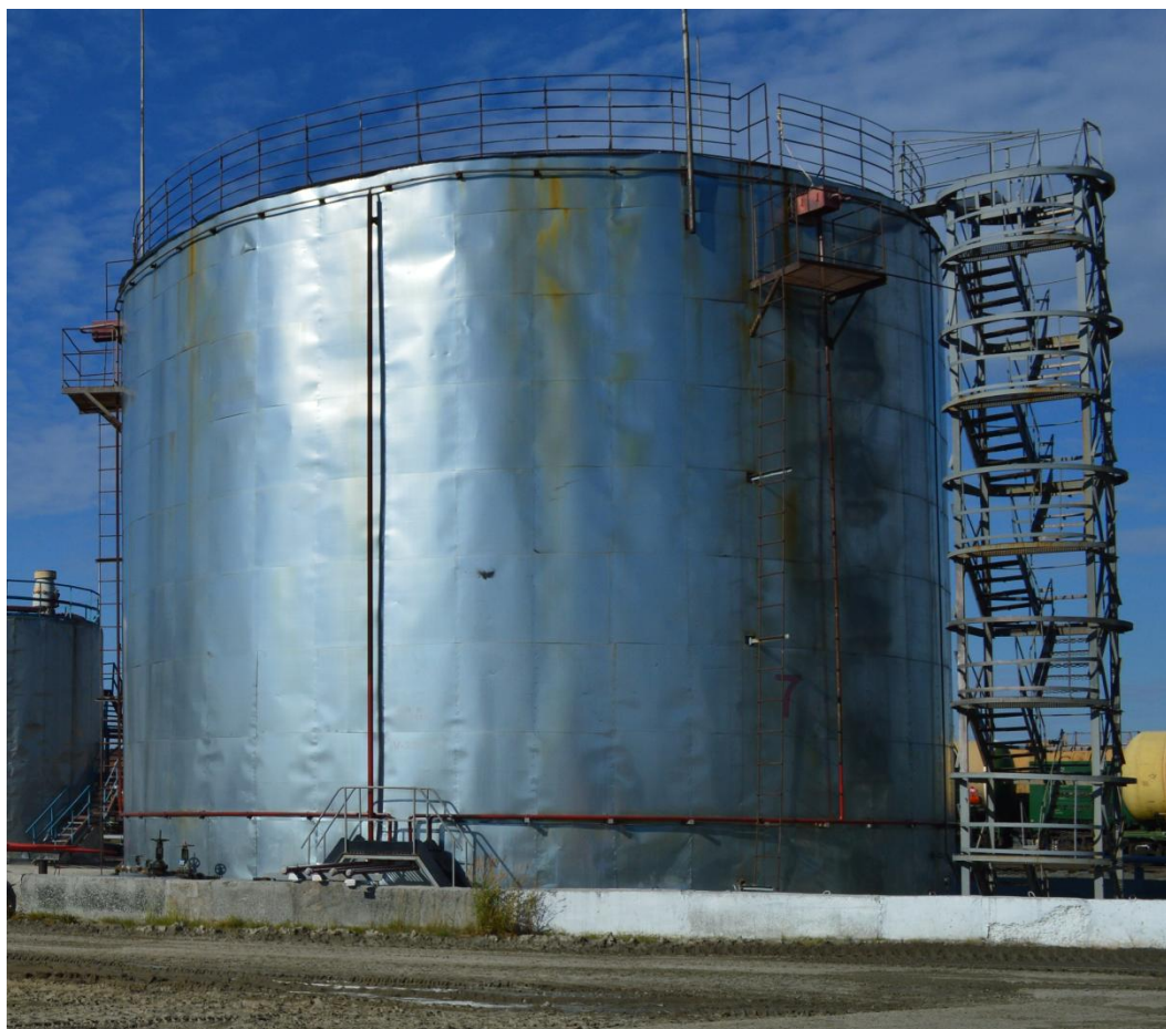
Рисунок 2 – Общий вид резервуара РВС-2000
