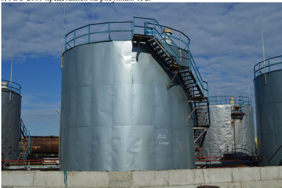
Рисунок 1 – Общий вид резервуара РВС-400
