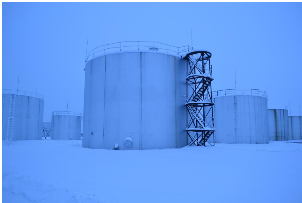
Рисунок 1 - Общий вид резервуара РВС-1000
