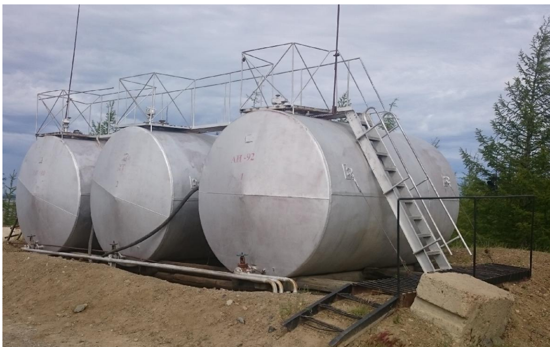
Рисунок 1 - Общий вид резервуара РГС-25
