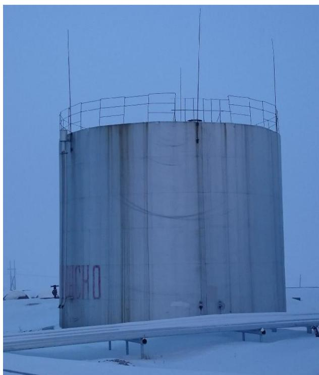
Рисунок 1 - Общий вид резервуара РВС-700
