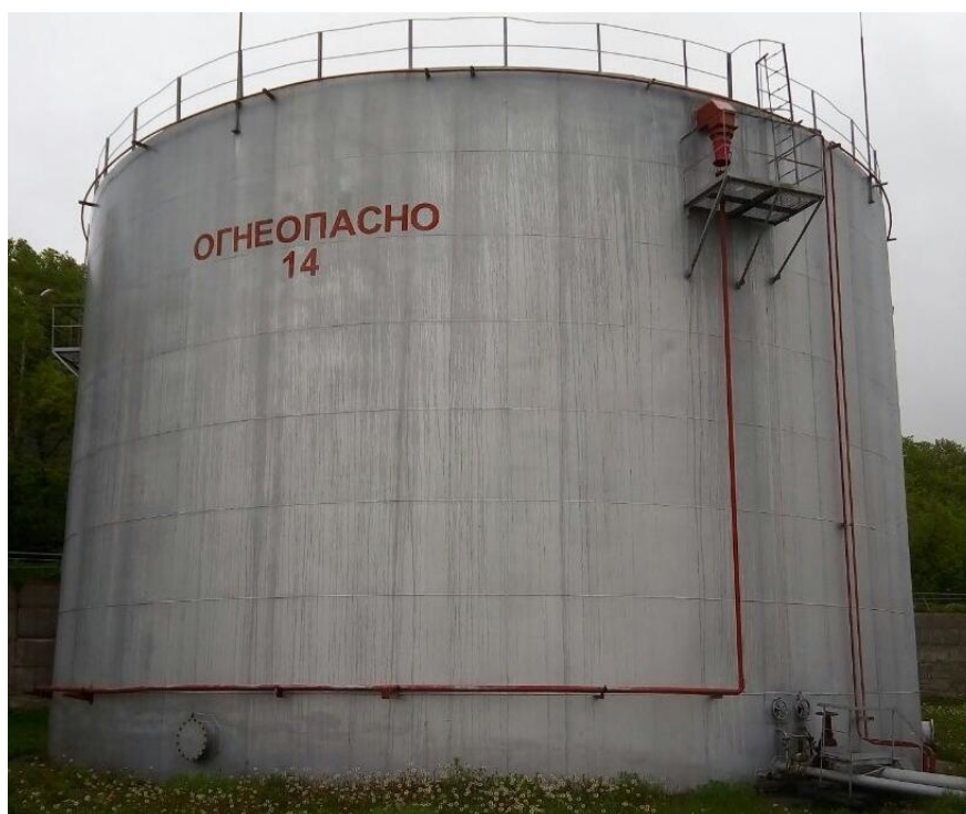
Рисунок 3 - Общий вид резервуара РВС-3000
