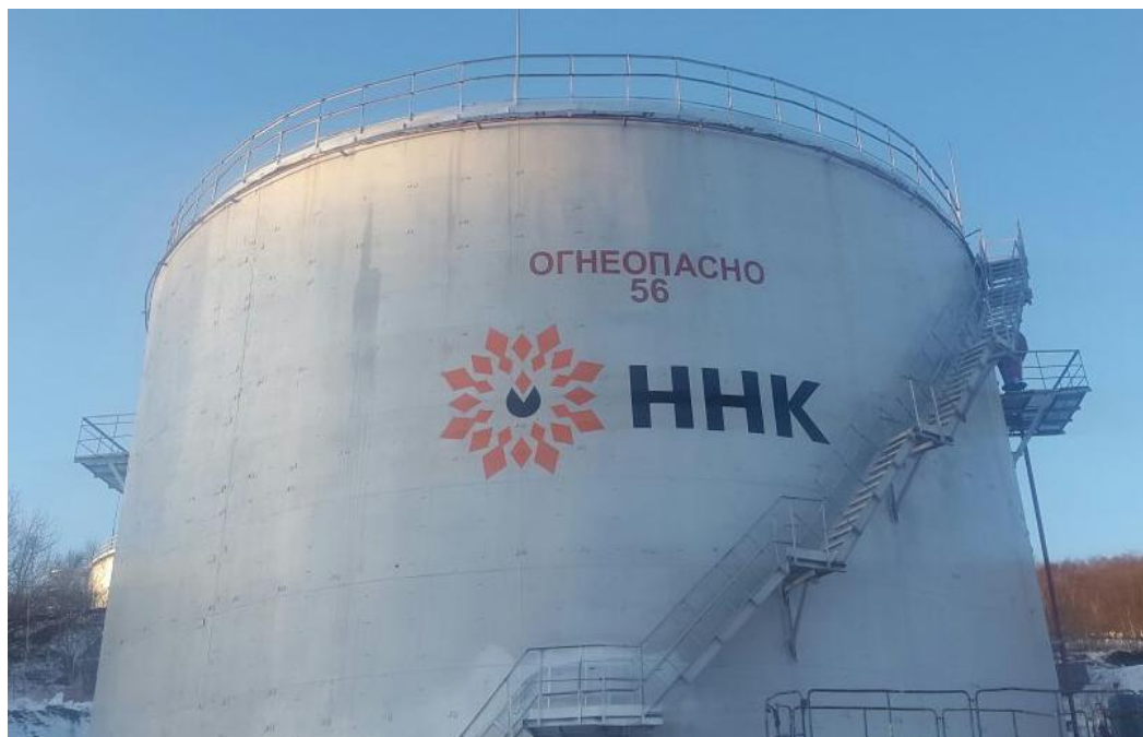
Рисунок 4 - Общий вид резервуара РВС-5000
