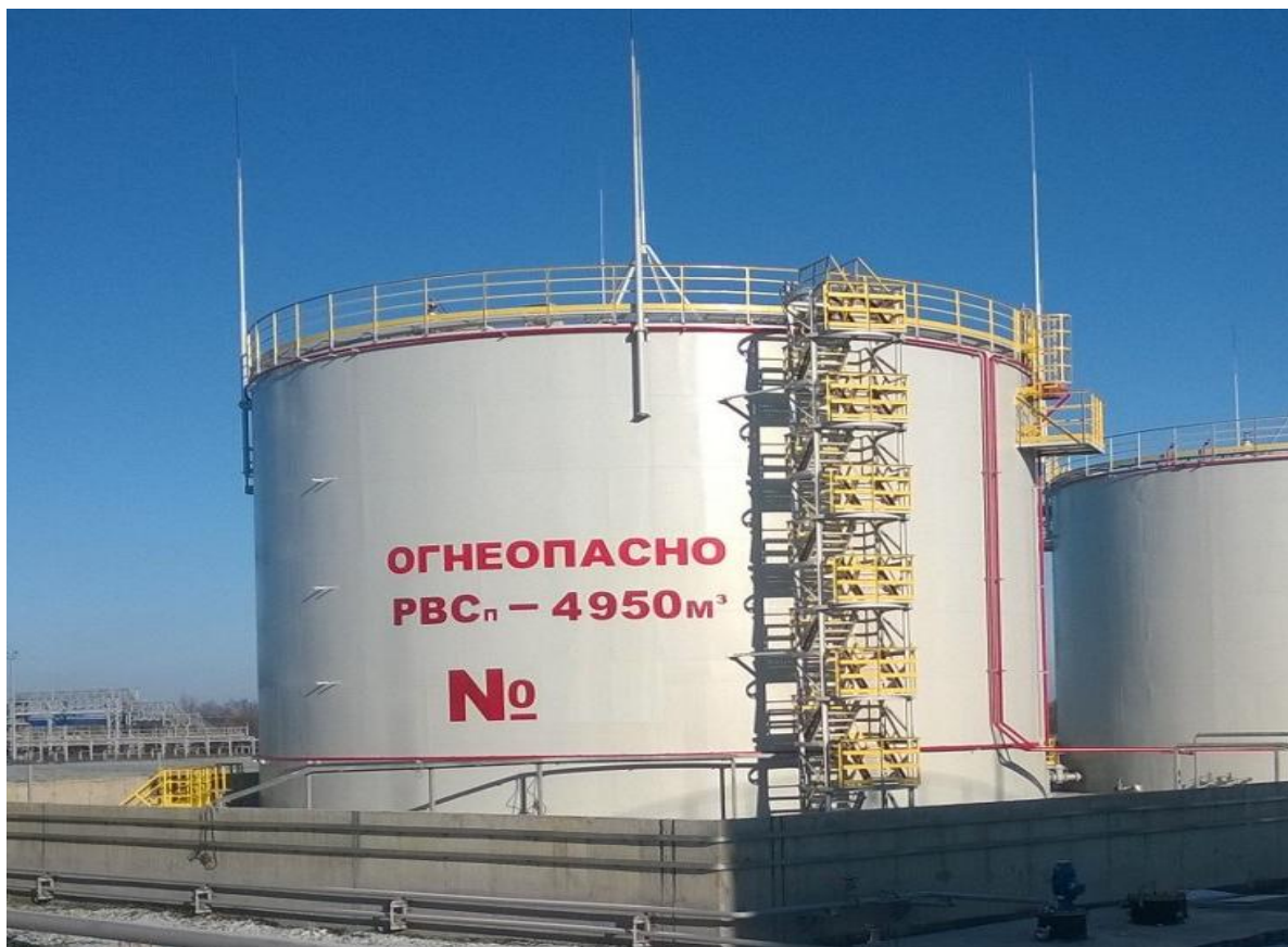
Рисунок 1 - Общий вид резервуаров вертикальных стальных РВСп-4950
