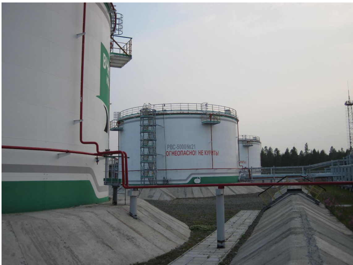
Рисунок 1 - Общий вид резервуаров вертикальных стальных цилиндрических РВС-5000
