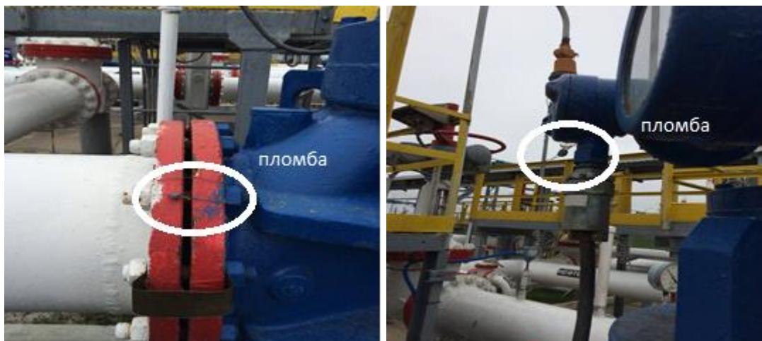
Рисунок 2 - Схема пломбировки от несанкционированного доступа, обозначение места нанесения знака поверки
