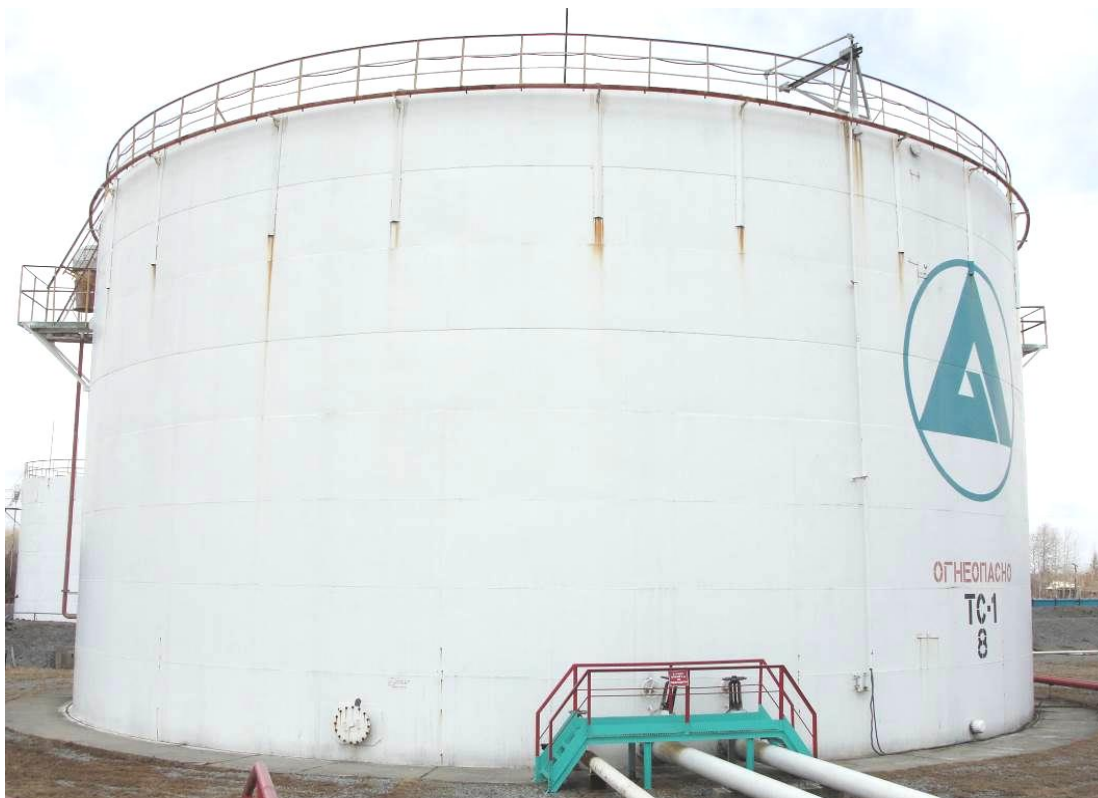
Рисунок 1 - Общий вид резервуара РВС-5000
