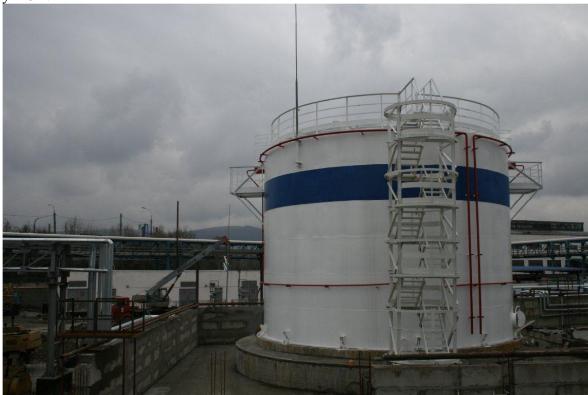
Рисунок 1 – Общий вид резервуара РВС-1000
