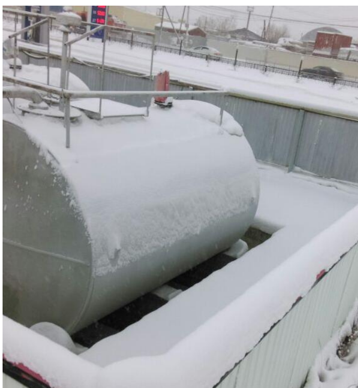
Рисунок 1 – Общий вид резервуара РГС-25
