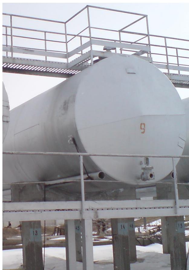
Рисунок 3 – Общий вид резервуара РГС-60
