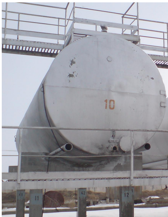
Рисунок 2 – Общий вид резервуара РГС-50
